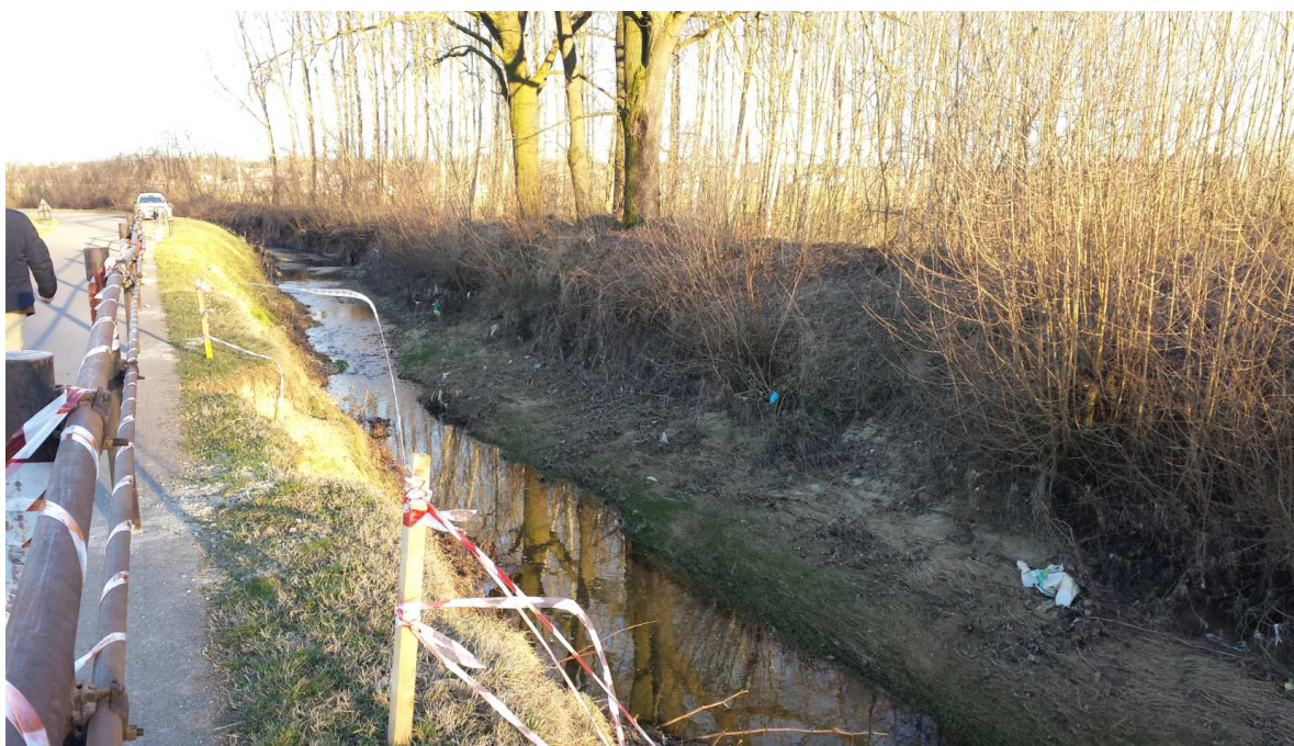
Figura 6.1 – Rio Pocapaglia nel tratto oggetto dei lavori
