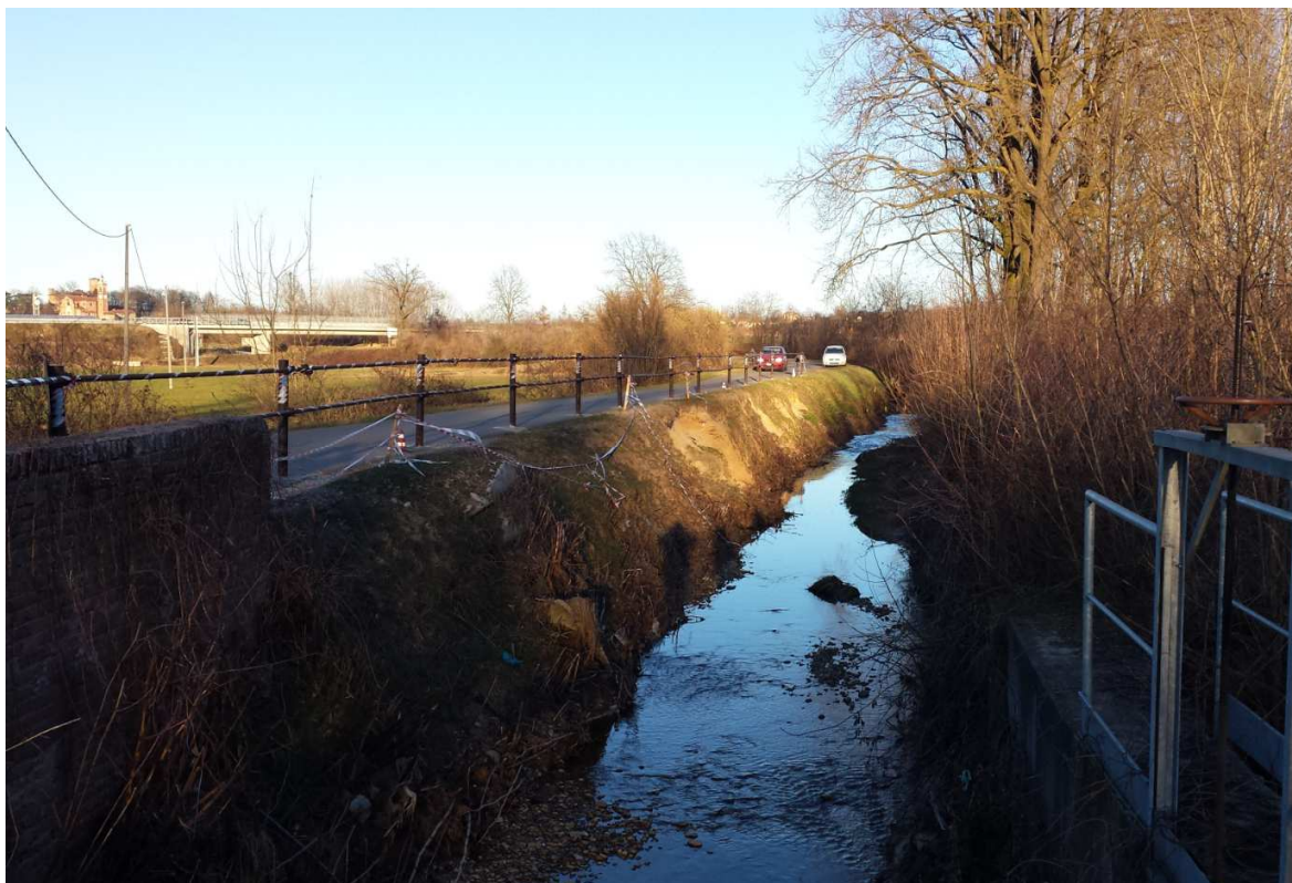
Figura 6.2 – Rio Pocapaglia e relativa scarpata nel tratto oggetto dei lavori
