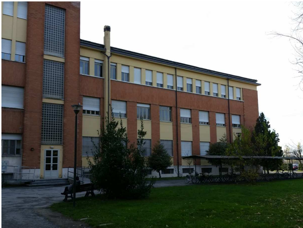
Fig. 3 Vista del prospetto principale - Ala Scuole Medie
