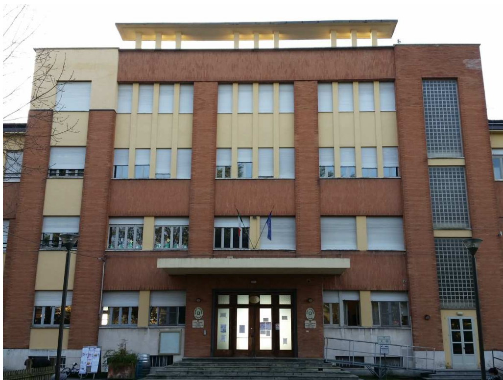
Fig. 1 Vista del prospetto principale
