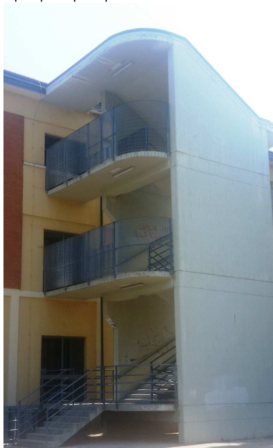
Fig. 4 Vista della scala esterna di esodo
